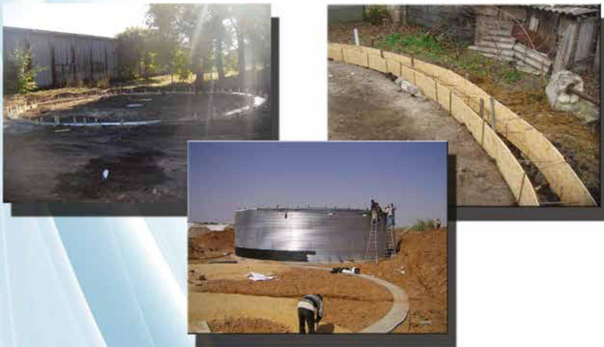
Модульные емкости могут устанавливаться **частично заглубленно** на глубину до 2,37 м с последующей обсыпкой грунтом и частичным бетонированием.
