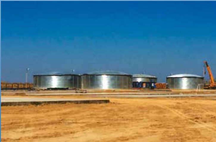
Две емкости по 1500 м 3 и две емкости по 2000 м 3 . Водоснабжение газоперераба- тывающего завода. Емкости монтируются в пустыне с мини- мальной грузоподъемной техни- кой и инструментом. Заказчик: MG Construction Equipment (ОАЭ). Инвесторы – Hyundai (Ю.Корея) и Лукойл (Россия). Место установки - г.Каракуль, Узбекистан.
