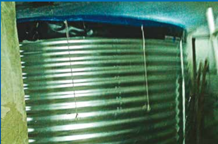
Два резервуара пожаротушения по 37 м 3 . Смонтированы в подвале, расто- яние от стенки емкости до стены здания по 30 см с каждой сторо- ны. Заказчик – ООО «Ангелит» (г. Киев). Место установки – г. Винница.
