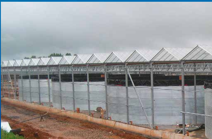
Три емкости 50,60 и 90 м 3 для технологической горячей воды с утеплением. Температура воды – 75°С. Установлены на льняной фабрике. Заказчик – ООО «Крафт Корпорэйшн» (г. Днепр). Место установки - г. Ровно.
