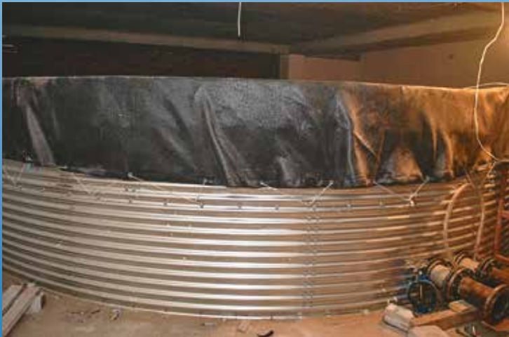
Емкость 62 м 3 для пожарного запаса воды. Установлен в офисном центре. Заказчик – ООО «Строитель-П». Место установки - г. Днепр.
