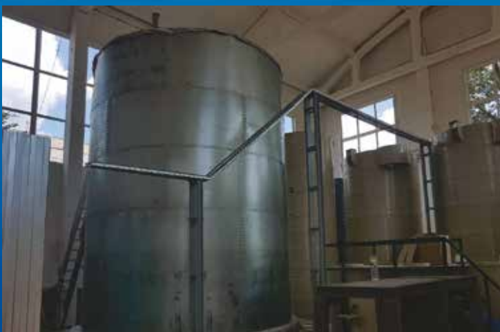
Емкость 96 м 3 в системе водо- подготовки на Комбинате «Злагода». Каркас емкости изготовлен по новой технологии с примене- нием ровных (не гофрирован- ных) листов. Место установки - г. Днепр.
