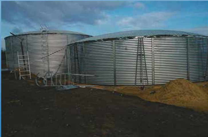
Две емкости по 1200 м 3 для во- доснабжения нескольких сел. Утеплены пенополистиролом. Место установки - смт.Великая Михайловка, Одесская обл.
