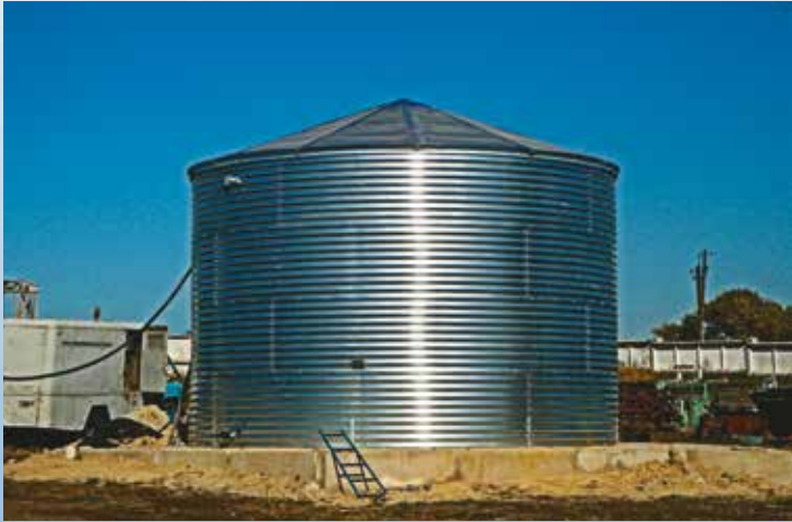
Емкость 200 и 250 м 3 для хранения КАС. Место установки - г.Старобельск, Луганская обл.
