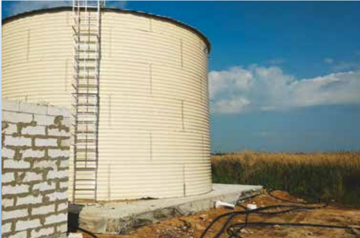
Емкость 500 м 3 . Питьевое и пожарное водоснаб- жение пансионата «Рута» . Емкость дополнительно окраше- на в корпоративные цвета Заказ- чика. Место установки - пгт. Затока, Одесская обл.
