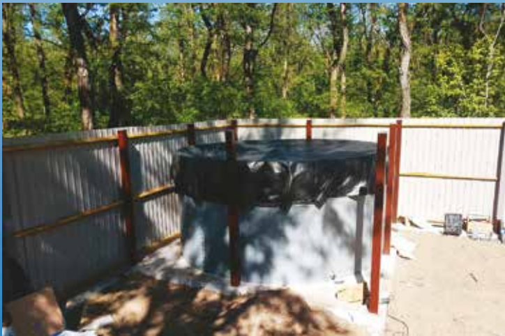
Емкость 18 м 3 с пластиковой крышей для полива газона. Место установки - пгт. Обуховка, Днепропетровская обл.
