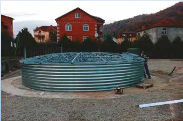
Емкость 148 м 3 для полива футбольного поля. Место установки - г.Сочи, Россия.
