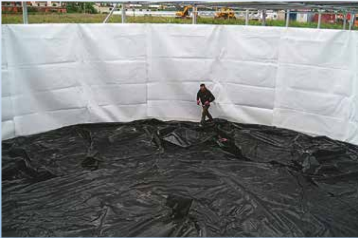
Емкость 160 м 3 для теплицы. Емкости укомплектованы выводными отводами диаметром 300 мм. Место установки – г. Днепр.
