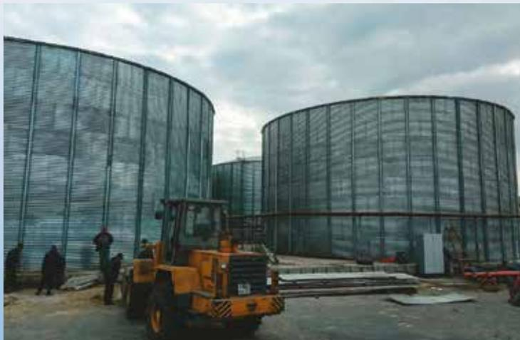
**Три емкости по 2600 м<sup>3</sup>, одна емкость 3500 м<sup>3</sup>**
