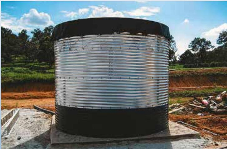
**Емкость объемом 13,5 м<sup>3</sup> для хранения воды в теплице.**
