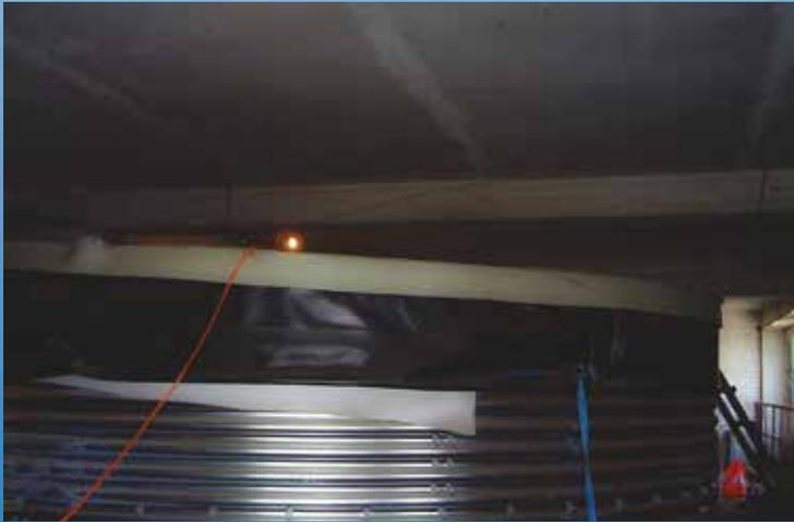
**Емкости 6 штук объемом по 16 м<sup>3</sup> для горячей воды (до 70°С).**
