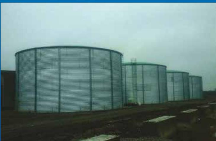
**Четыре емкости для КАС объемом по 1027 м<sup>3</sup> (склад КАС).** Выполнена обвязка емкостей, подключение насосов и запуск емкостей. В емкостях также может храниться КЖУ. Место установки – г. Синельниково, Днепропетровская обл.
