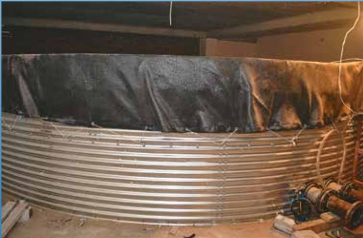
**Емкость 62 м<sup>3</sup> для пожарного запаса воды.**
