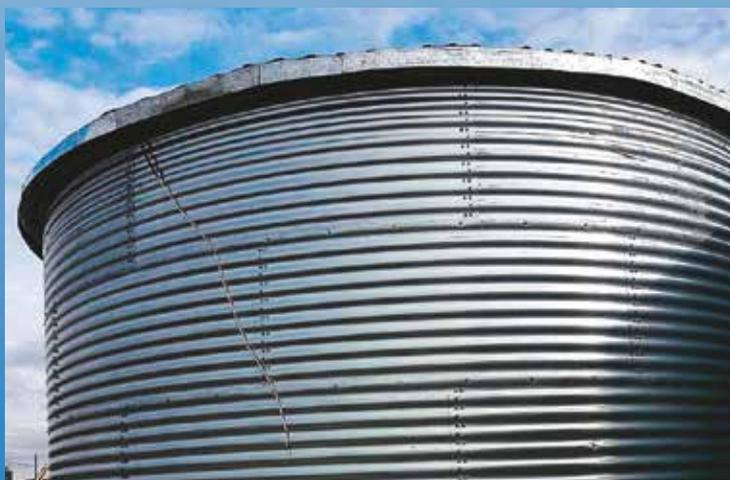
**Два пожарных резервуара по 750 м<sup>3</sup>.**
