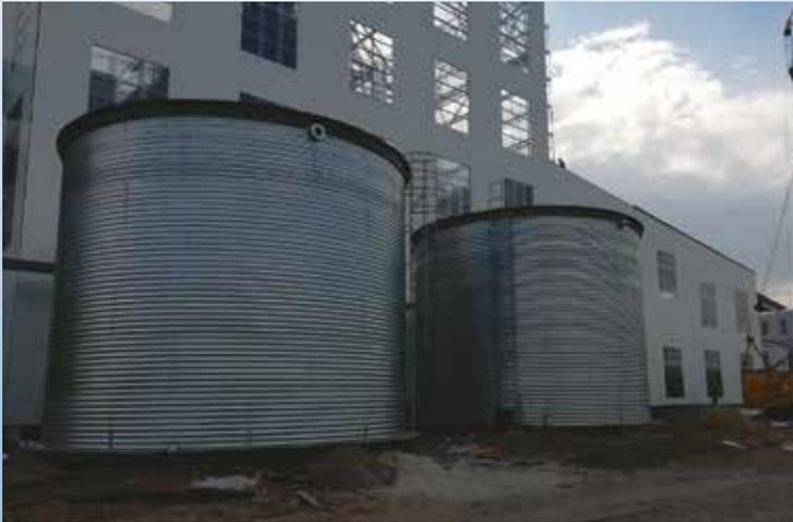
**Две емкости по 500 м<sup>3</sup> для пожаротушения**
