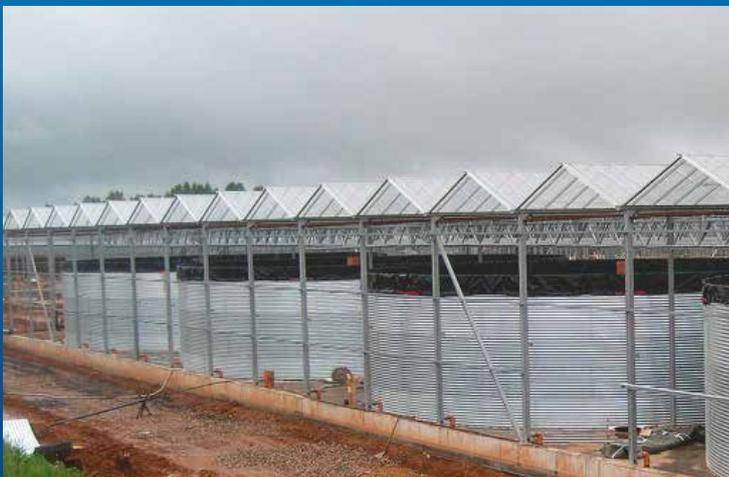
**Три емкости 50,60 и 90 м<sup>3</sup> для технологической горячей воды с утеплением.**
