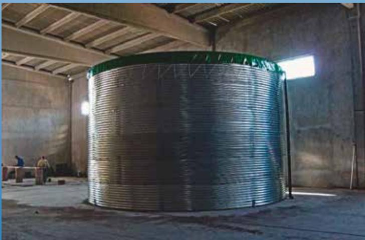
**Емкость объемом 50 м<sup>3</sup> для пожарного запаса воды.**
